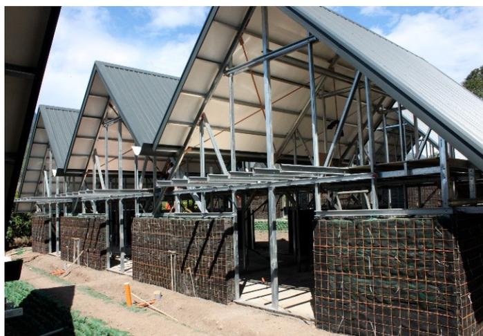
圖1.5 採以工代賑完成的輕鋼構造八八風災重建永久屋，建議在CO<sub>2</sub>減量、廢棄物減量等指標上可被認定為滿分
