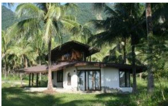
圖1.3(左) 以固定捏土牆工法、造型泥塑、編竹夾泥牆等自然建築工法建造的「阿牛村」，可在日常節能、CO<sub>2</sub>減量、廢棄物減量等指標上建議可被認定為滿分
